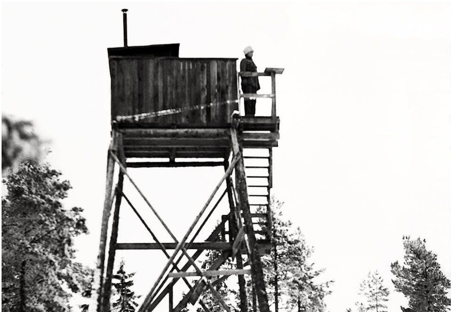
Personalen vid luftbevaknings-stationerna skulle i första hand upptäcka, rapportera och typbestämma luftfarkoster. Foto av ett luftbevakningstorn i trä från 1942. © TT nyhetsbyrån
